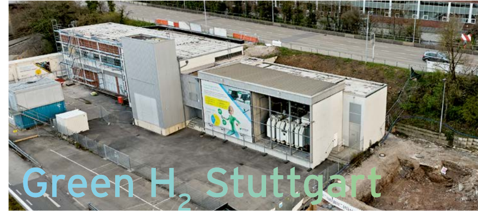
Baufortschritt des Green Hydrogen Hub im Stuttgarter Hafen im März 2026
